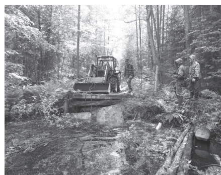
Ремонт моста через реку Витьюм
