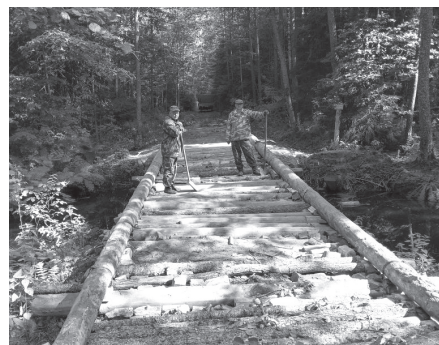
Мост через реку Витьюм
